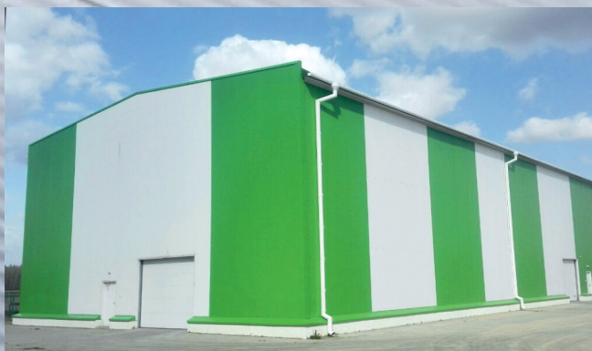
Склад ООО «Вегас» г. Брест
