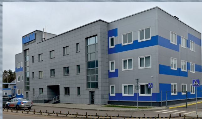
ООО «Халекс» Административно-бытовое помещение
